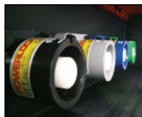
Abgänge mit CEE-Steckdosen Einspeisung mit Powerlock
